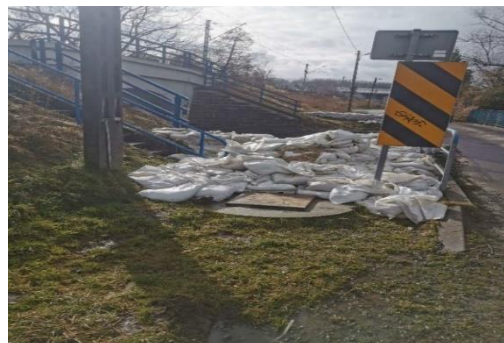
Zdj. 7 i 8. Doraźne zabezpieczenia mostu powstałe w ramach współpracy mieszkańców i służb.
