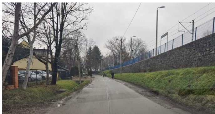
Zdj. 11. Miejsce na chodnik po stronie stacji kolejowej. Piesi wybierają tę stronę.
