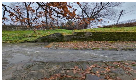
Zdj. 9 i 10. Pożądanе miejsce wychwytu i kanał spływu do zbiornika opadów z ulic Zolla i Ślósarczyka
