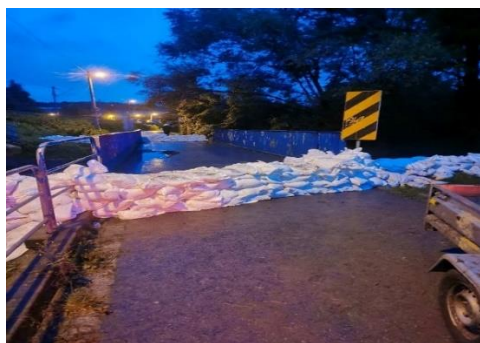
Zdj. 7 i 8. Doraźne zabezpieczenia mostu powstałe w ramach współpracy mieszkańców i służb.
