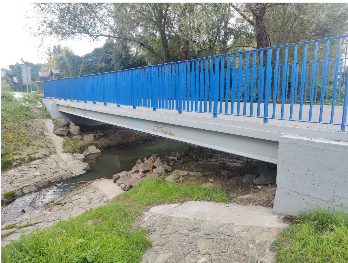
Fot. 1 Most w ciągu ul. Rakuś
