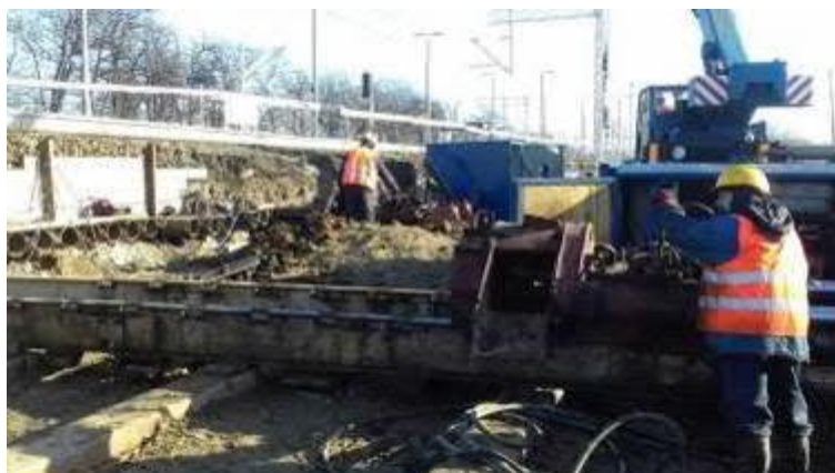
Zdjęcie z przykładowej realizacji. Wiertnica w trakcie wykonywania pipe-roofingu
