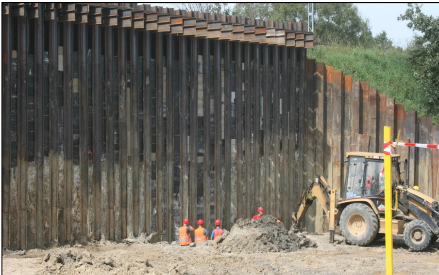
Zdjęcie z przykładowej realizacji. Ściana czołowa na przodzie komory nadawczej
