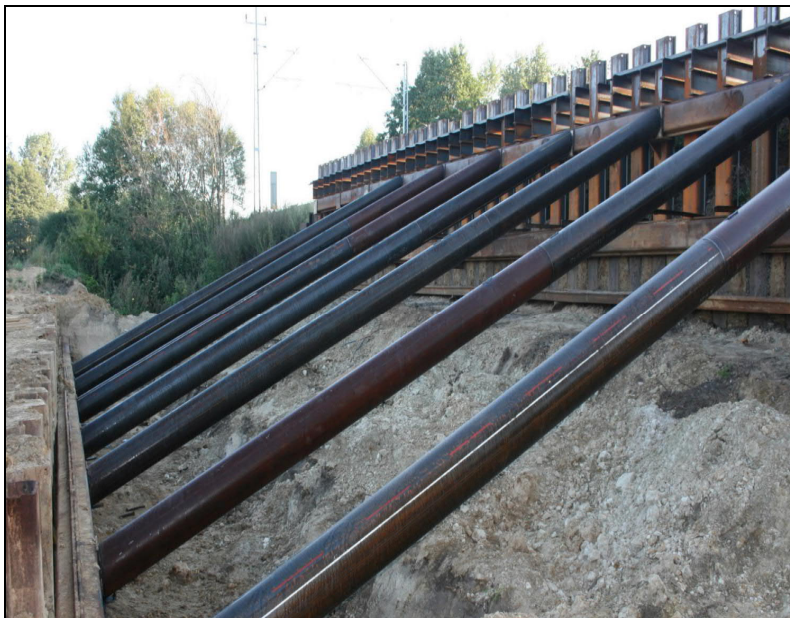
Zdjęcie z przykładowej realizacji. Widok na ścianę oporową z zaparciem.
