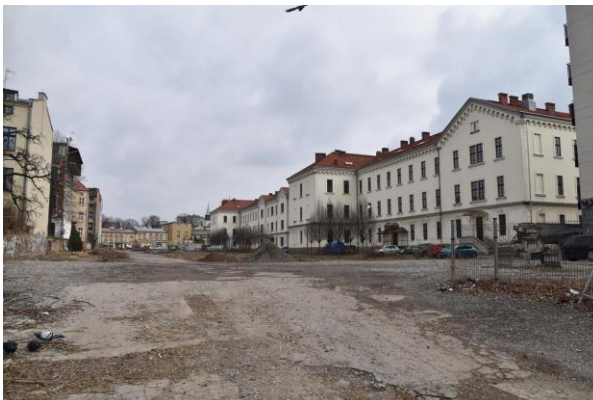
Fot. 15 Plac budowy (planowany park) przed gmachem Wojewódzkiej Biblioteki przy ul. Rajskiej, widok od strony zachodniej – obszar nad planowanym przystankiem „Stare Miasto” (źródło: Ekovert)
