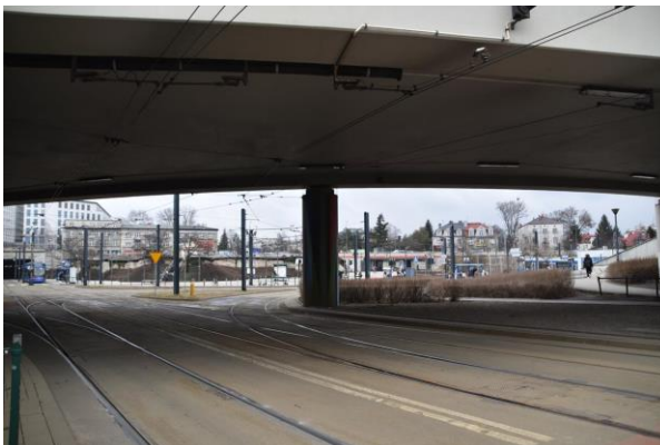
Fot. 26 Torowisko pod Rondem Mogilskim – miejsce znajdujące się częściowo w zasięgu przedsięwzięcia (źródło: Ekover)
