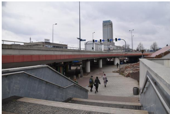
Fot. 27 Zejście do węzła przesiadkowego pod Rondem Mogilskim (źródło: Ekover)
