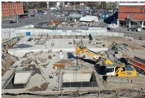
Fot. 94 Budowa przystanku Łódź Polesie (źródło: https://inzynieria.com/geoinzynieria/wiadomosci/63958,sciany-szczelinowe-na-przystankach-tunelu-srednicowego-w-lodzi )
