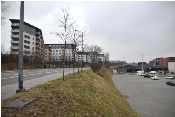
Fot. 40 Widok na skarpe między ul. Dobrego Pasterza a parkingiem przy centrum handlowym „Serenada” - obszar planowanego początku części nadziemnej inwestycji (źródło: Ekovert)
