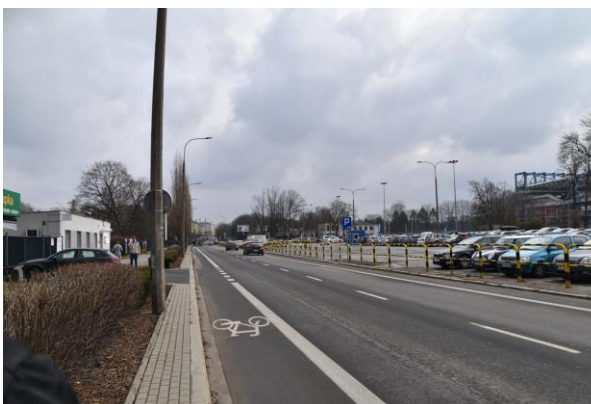
Fot. 5 Widok w kierunku wschodnim na ul. Reymonta, na wysokości Stadionu Miejskiego – obszar planowanego przedsięwzięcia (źródło: Ekovert)
