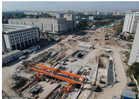
Fot. 96 Budowa metra na ul. Kondratowicza (źródło: https://warszawa.wyborcza.pl/warszawa/7,54420,26686370,nowe-nazwy-stacji-metra-ale-radni-pogubili-sie-w-zmianach-przystankowych.html )
