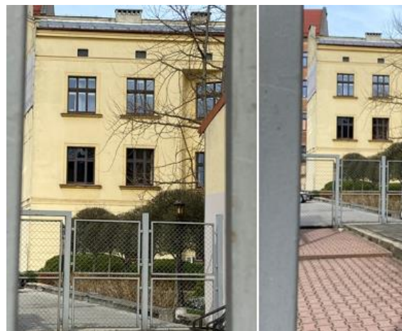
Fot. 76. Kamienica przy ul. Czystej 21- zabudowania znajdujące się bezpośrednio nad planowanym tunelem (źródło: Ekovert)
