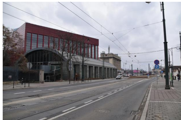
Fot. 25 Widok na ul. Lubicz i Operę Krakowską – obszar znajdujący się częściowo nad planowaną inwestycją (źródło: Ekovert)
