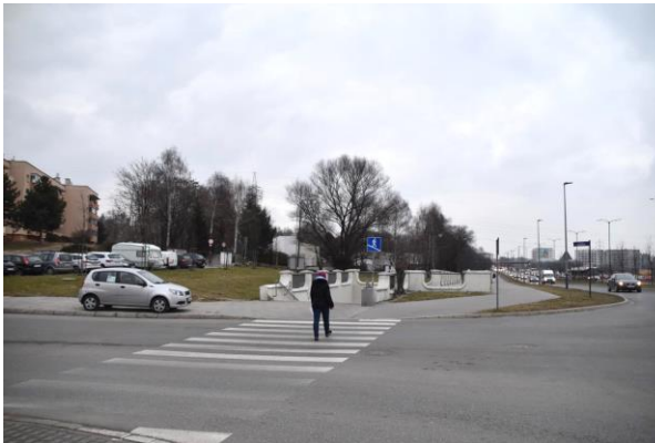
Fot. 48 Przejście podziemne przy ul. Książnica – obszar znajdujący w zasięgu części nadziemnej planowanego przedsięwzięcia (źródło: Ekovert)
