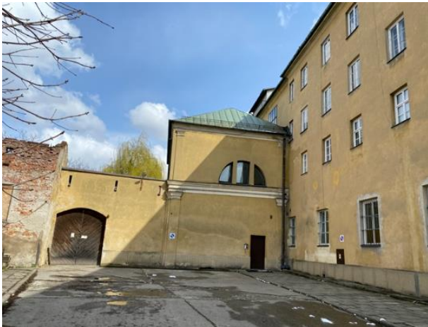
Fot. 77. Klasztor przy ul. Karmelickiej 19 – zabudowania znajdujące się nad planowanym tunelem (źródło: Ekovert)
