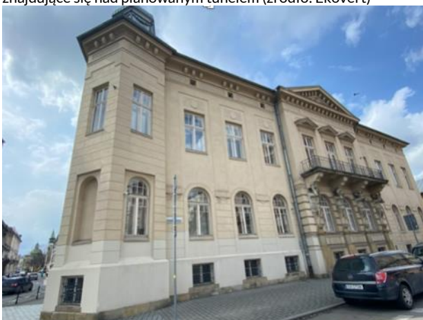
Fot. 79. Pałac Tyszkiewiczów ul. Asnyka 2/ul. Garbarska 1 – zabudowania znajdujące się nad planowanym tunelem (źródło: Ekovert)
