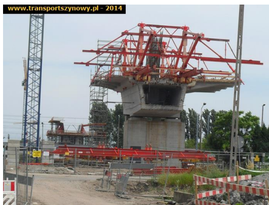
Fot. 92 Budowa estakady tramwajowej w Krakowie w ramach Krakowskiego Szybkiego Tramwaju - 2014 r. (źródło: https://www.transportszynowy.pl/fotorelacje/krestakada-tram )
