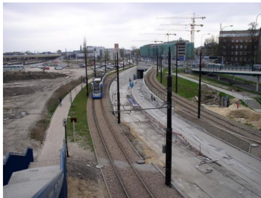
Fot. 90 Budowa rampy wjazdowej do tunelu Krakowskiego Szybkiego Tramwaju w ok. Ul. Pawiej - 2008 r. (źródło: https://pl.wikipedia.org/wiki/Tunel_Krakowskiego_Szybkiego_Tramwaju )
