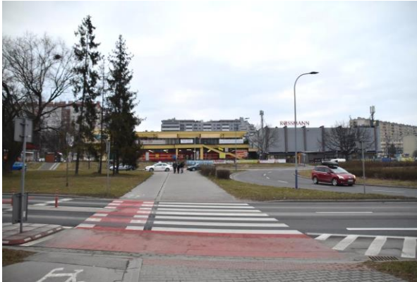
Fot. 58 Widok na północną część Ronda Maczka oraz DH „Wanda” – obszar planowanego przedsięwzięcia (źródło: Ekoverť)
