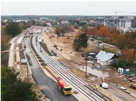
Fot. 89 Przykład prac związanych z budową torowiska w Warszawie (źródło: https://tustolica.pl/w-20-minut-dometra-finish-na-budowie-torowiska-tramwajowego_83942 )
