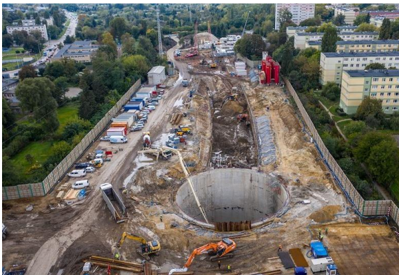
Fot. 95 Przygotowania do drażenia tunelu średnicowego w Łodzi (źródło: https://lodz.wyborcza.pl/lodz/7,35136,26934131,tunel-dla-kolei-duzych-predkosci-w-lodzi-krok-blizej-budowy.html )
