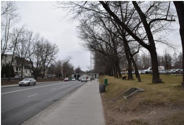
Fot. 36 Widok na ul. Pilotów na wysokości ul. Podmiejskiej – obszar nad planowanym tunelem (źródło: Ekovert)
