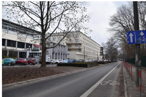
Fot. 8 Ul. Reymonta w okolicy Hotelu Studenckiego „Nawojka” – początek odcinka podziemnej części przedsięwzięcia (źródło: Ekovert)
