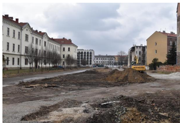
Fot. 14 Plac budowy (planowany park) przed gmachem Wojewódzkiej Biblioteki przy ul. Rajskiej, widok od strony wschodniej – obszar nad planowanym przystankiem „Stare Miasto” (źródło: Ekovert)
