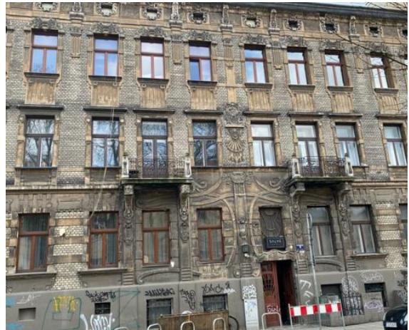
Fot. 78. Kamienica przy ul. Łobzowskiej 4 – zabudowania znajdujące się nad planowanym tunelem (źródło: Ekovert)
