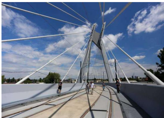
Fot. 97 Estakada tramwajowa nad linią kolejową Kraków-Łódź (źródło: https://inzynieria.com/fotogalerie/branzy/fotogaleria/6/875,proby-obciazeniowe-estakady-tramwajowej-w-krakowie,zdjecie-11 )
