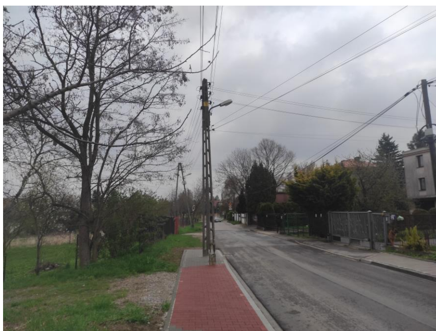
Fot. 1 Widok na początek opracowania na ul. Borowinowej
