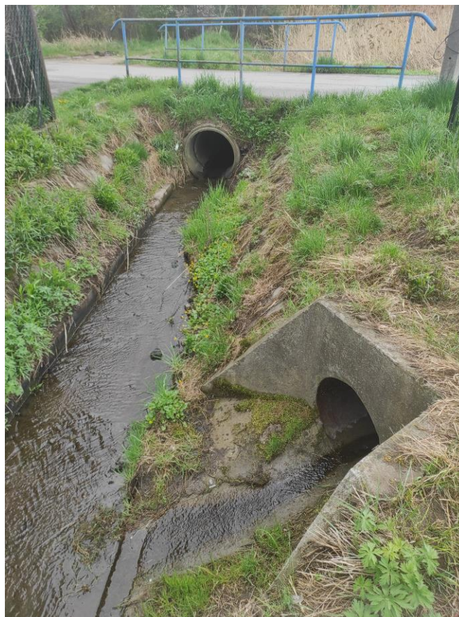
Fot. 6 Istniejące zagospodarowanie w rejonie przepustu
