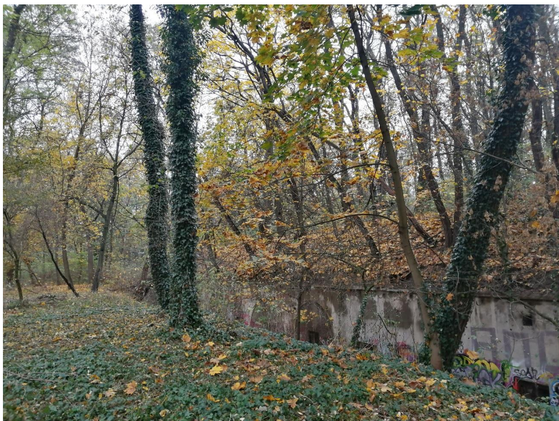
Ryc. 17. Widok z dachu koszar szyjowych na schron główny. [źródło: materiały własne]
