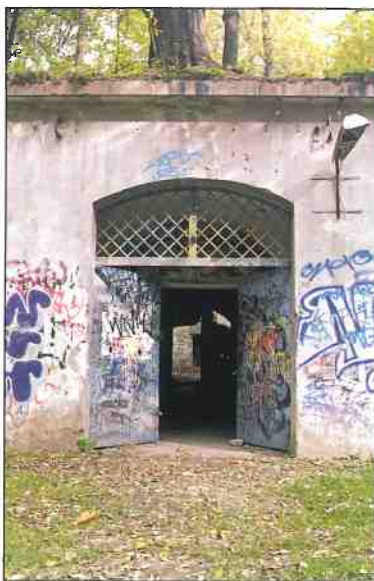
Widok bramy głównej koszar szyjowych (fot. M. Szkoła, 2007)
