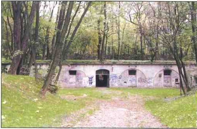
Widok dziedzińca z drogi dojazdowej od zapola (fot. M. Szkoła, 2007)
