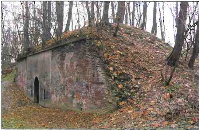
Poprzecznica z wejściem do poterny do kaponiery podwójnej na osi fortu (fot. M. Szkoła, 2007)
