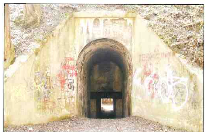
Wejście do schronu głównego (fot. J. Kubicha, 2004)
