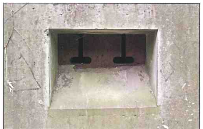
Detal kaponiery: strzelnica depresyjna z płytą pancerną (fot. M. Szkoła, 2007)
