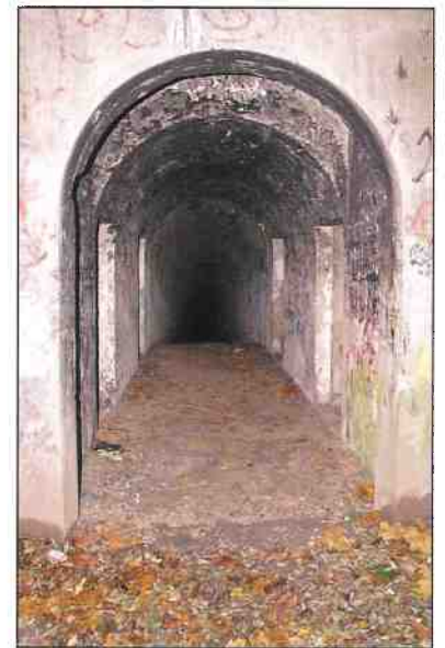
Wejście do poterny do kaponiery podwójnej na osi fortu (fot. M. Szkoła, 2007)
