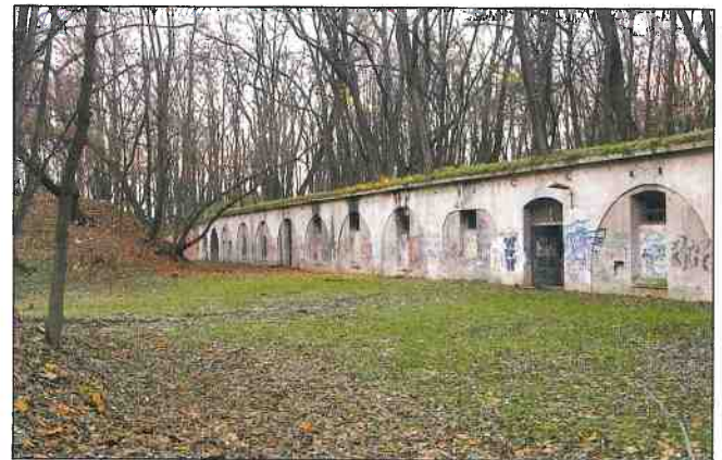
Ogólny widok dziedzińca z elewacją koszar szyjowych (fot. M. Szkoła, 2007)
