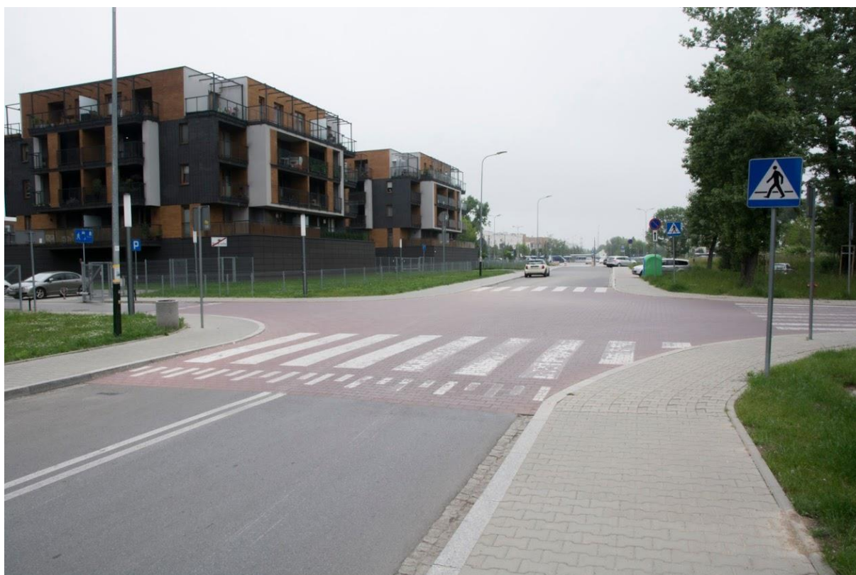
Zdjęcie 13. Wyniesione skrzyżowanie( Kraków).
