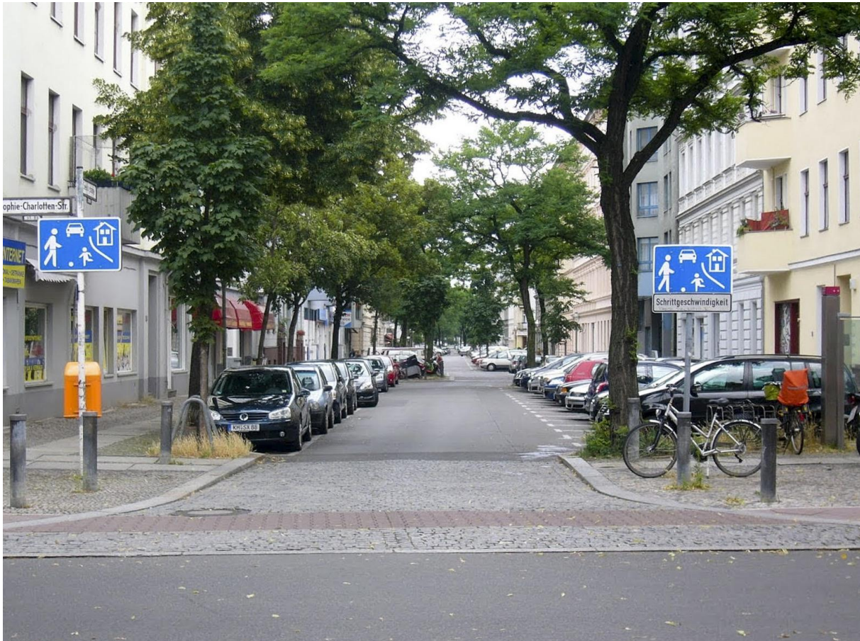
Zdjęcie 2. Wjazd do granicy strefy zamieszkania oznaczony wyniesionym przejściem oraz zwężoną jezdnią z licznymi nasadzeniami (Berlin, Niemcy).
