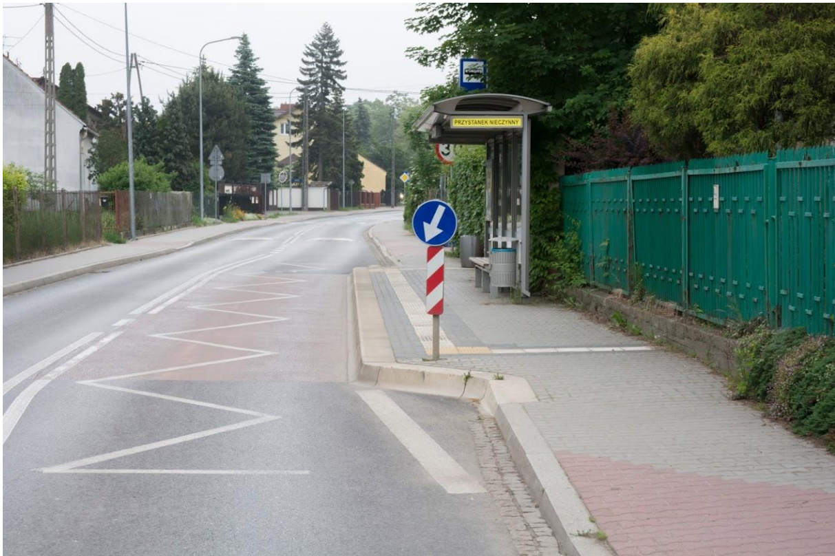
Rysunek 16. Przystanek autobusowy z wysuniętą krawężnią peronu - tzw. Antyzatoka (Kraków).
