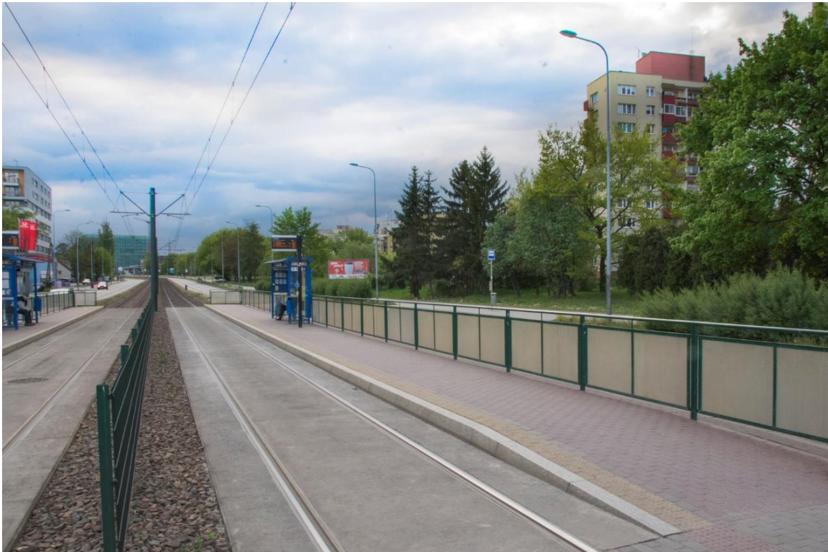
Zdjęcie 19. Wydzielony przystanek tramwajowy (Kraków).
