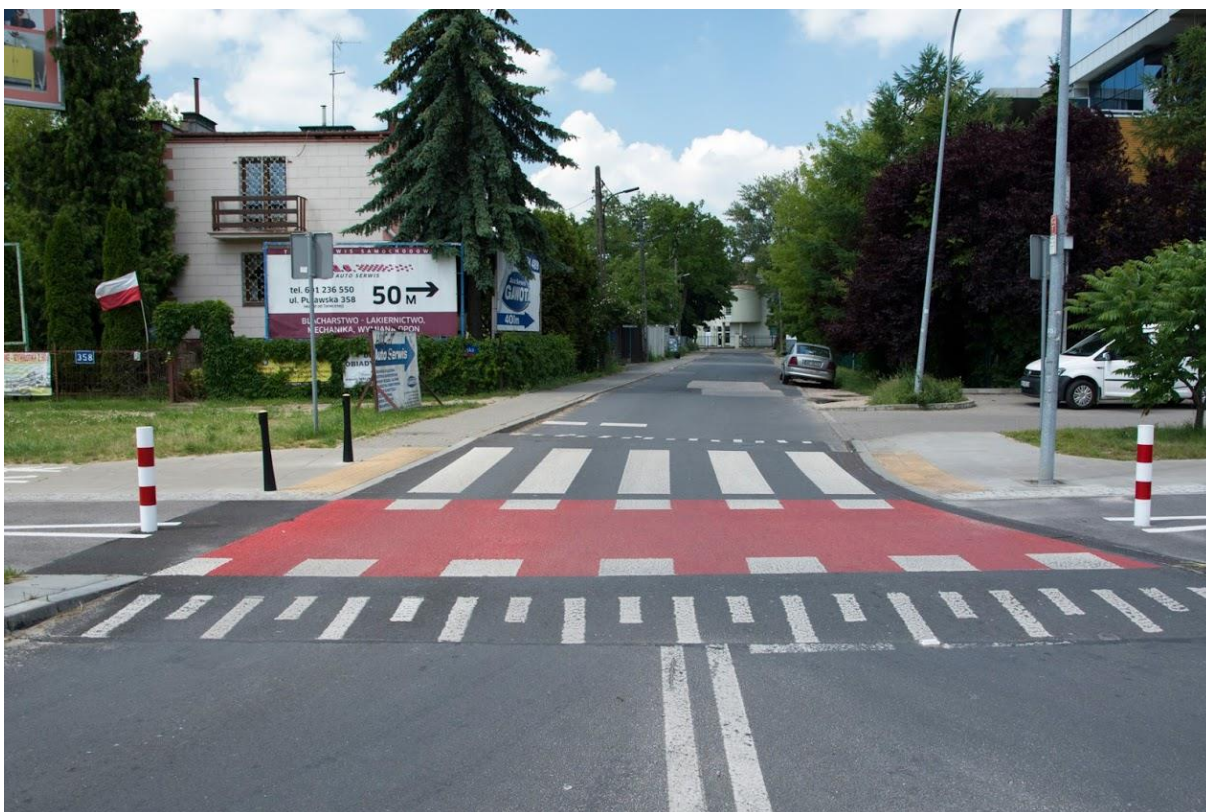
Zdjęcie 12. Przejście dla pieszych i przejazd dla rowerzystów na wyniesionym progu na wlocie ulicy (Warszawa).
