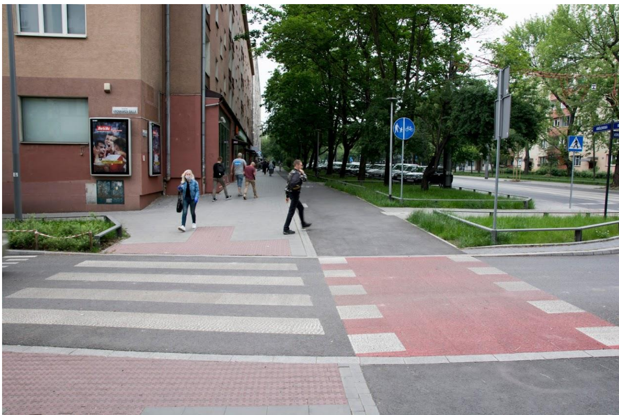
Zdjęcie 11. Przejście dla pieszych oraz przejazd dla rowerzystów na wyniesionym progu na wlocie ulicy (Kraków).
