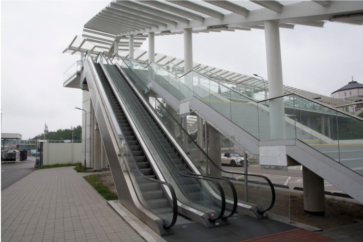
Rysunek 23. Schody ruchome oraz zwykłe w ramach przejścia nad torami kolejowymi (Kraków).
