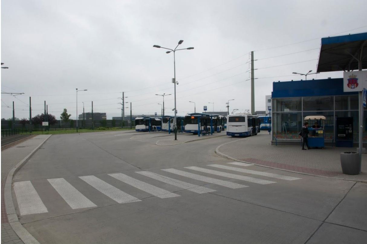
Zdjęcie 15. Przejście dla pieszych w obrębie pętli autobusowej (Kraków).
